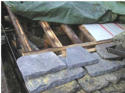
*Fig. 30 - Rifacimento di una copertura in pioda: si nota la differenza tra la parte che copre i locali interni (coibentata) da quella sopra la lobbia esterna con la pioda a vista*
