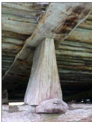
Fig. 6 – Pilastrini di sostegno al piano adibito a fienile/granaio (Dorca)
