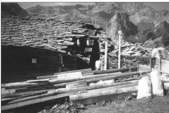
*Fig. 56 – I lavori di ristrutturazione: rimozione delle piode e demolizione del muro posteriore*
