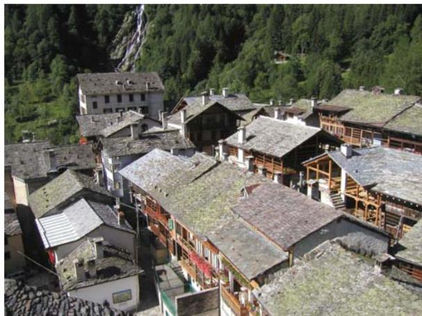
*Fig. 29 - Tetti in piode dell'abitato di Rima: le colorazioni chiare indicano gli interventi di rifacimento del manto con l'inserimento di piode nuove*
