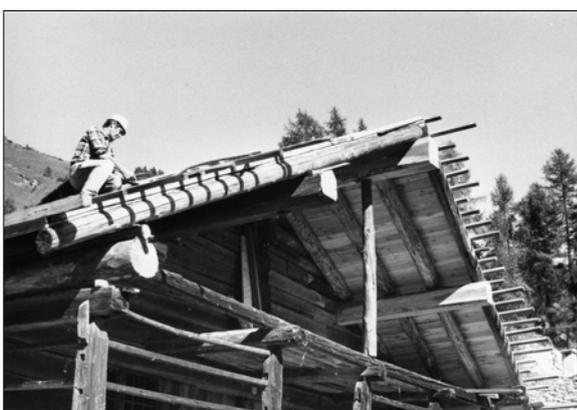
*Fig. 57 - I lavori di ristrutturazione: rifacimento del tetto*
