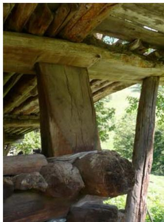
*Fig. 67 – Pilastrini di sostegno del piano del fienile/granaio*
