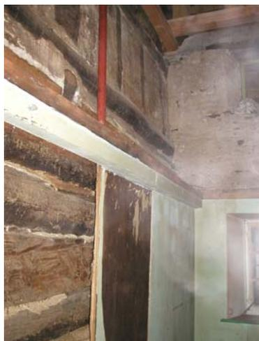
*Fig. 38 - Nuove strutture in legno inserite nell'edificio storico: l'integrazione tra le due strutture non cancella quella originaria, ma collabora con essa alla funzione portante lasciandola comunque visibile*
