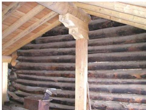
*Fig. 39 - Nuove strutture in legno inserite nell'edificio storico: l'integrazione tra le due strutture non cancella quella originaria, ma collabora con essa alla funzione portante lasciandola comunque visibile*
